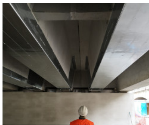
Beskyttelse af viaduktbjælker med Mapeshield E
