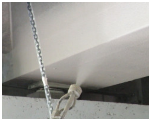
Overfladebehandling og beskyttelse af Mapeshield E med Mapelastic Guard Zero påført med spray
