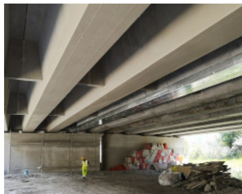
Bjælker beskyttet med Mapeshield E og Mapelastic Guard Zero
