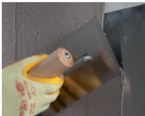
Overfladebehandling og beskyttelse af Mapeshield E med Mapelastic Guard Zero påført med murske
